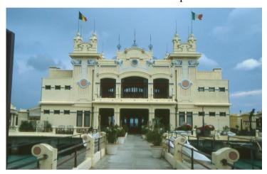
E'costituito da una piattaforma in calcestruzzo di c.a. su piloni cilindrici su cui è impostato con una rigida simmetria il corpo di fabbrica principale, da cui si dipartono, parallelamente all'arenile, le stecche costituite dalle cabine.
